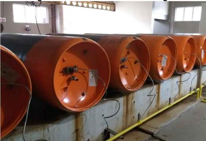
Figura 25: Armazenamento de cloro gás
