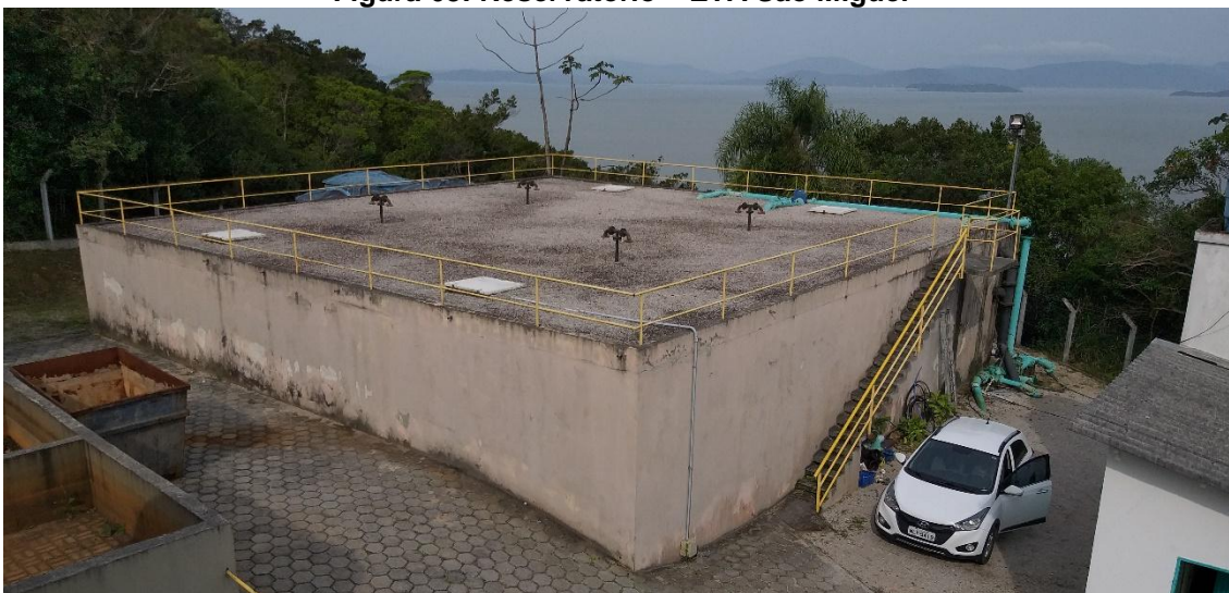
Figura 63: Reservatório – ETA São Miguel
