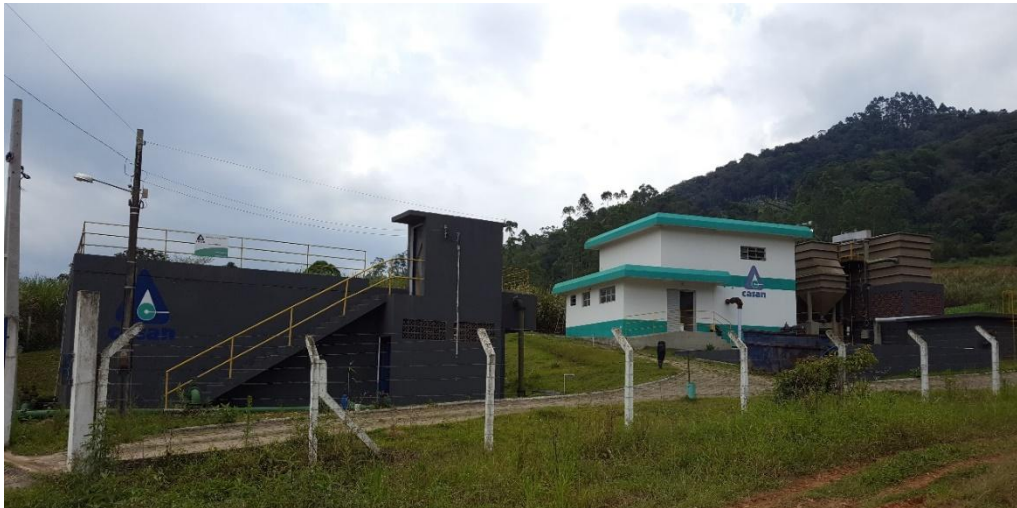
Figura 55: Estação de Tratamento de Água de Antônio Carlos
