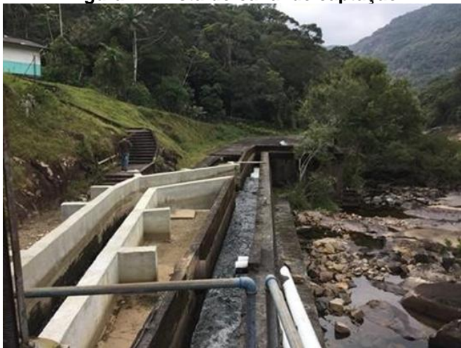
Figura 11: vista do canal de captação
