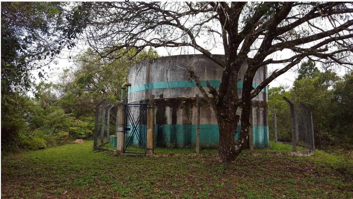
Figura 65: Reservatório 200 m 3
