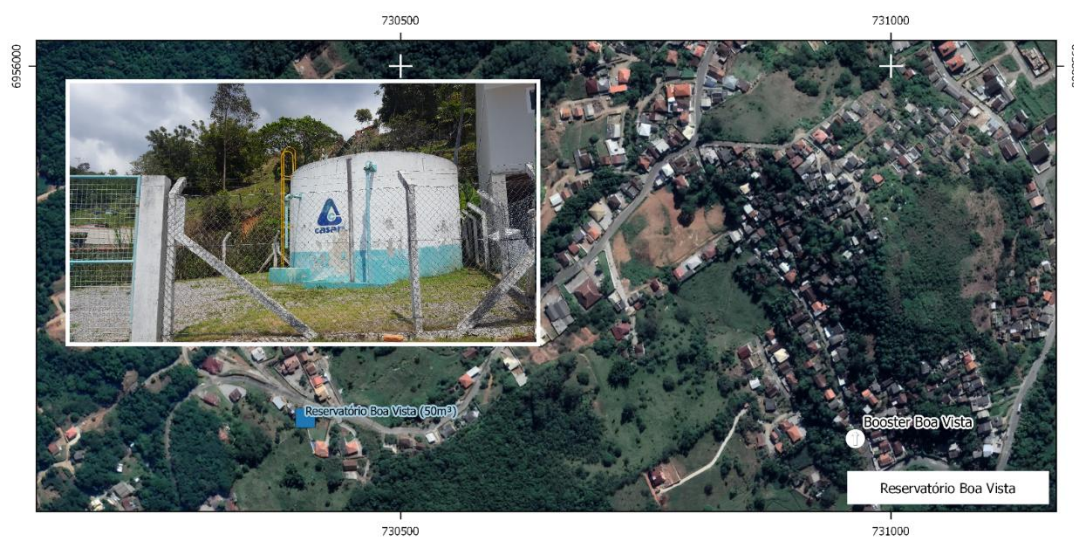
Figura 36: Reservatório Boa Vista
