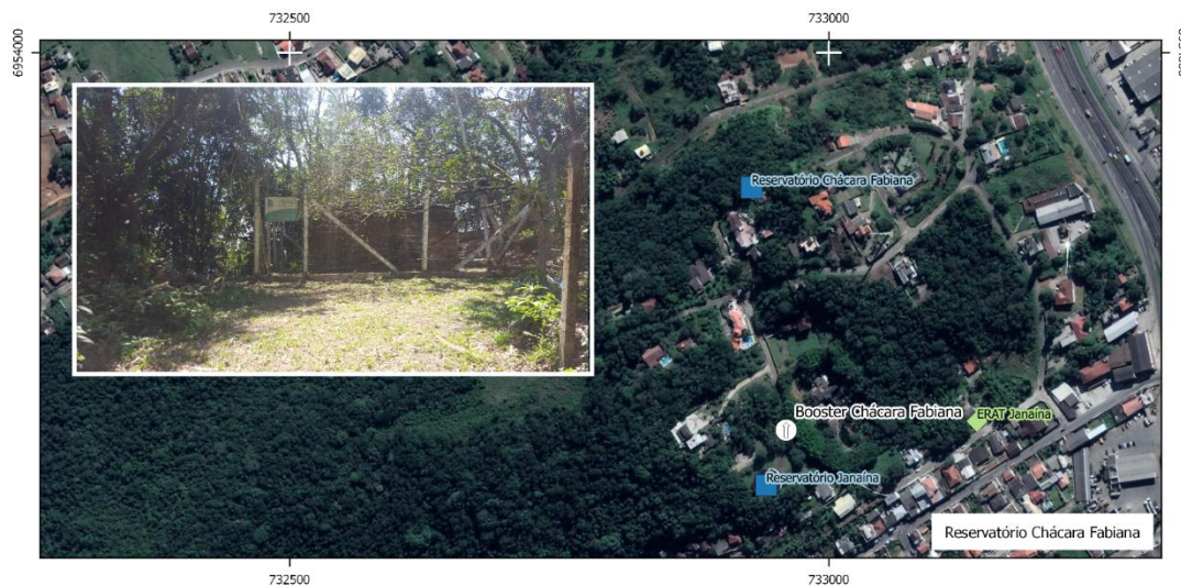
Figura 35: Reservatório Chácara Fabiana
