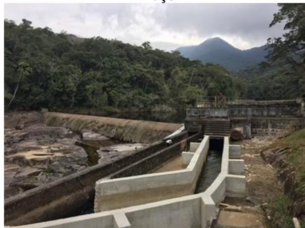
Figura 9: Barragem de captação no Rio Vargem do Braço
